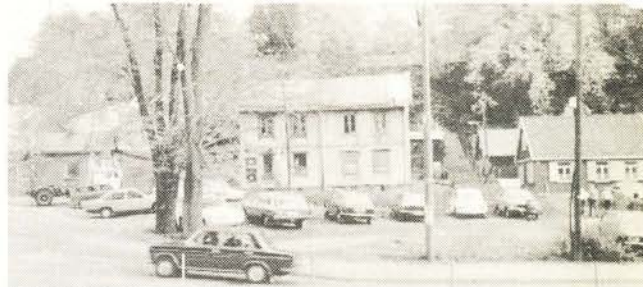
Brinken 65 . Vedtak om rehab. er en ting,gjennomføring i praksis er visst noe annet...
