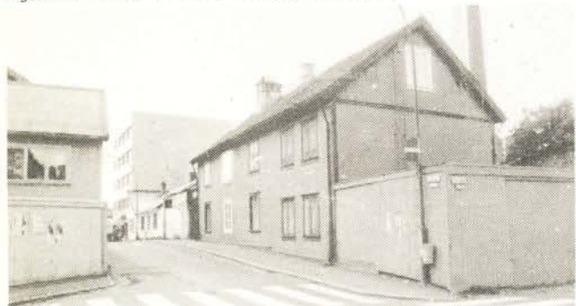
Kampengt.I3 har skiftet eier som nå skifter vinduer.
