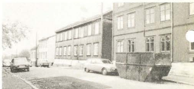
Container og sandhaug utenfor Sørumsgt.8&I0. Tydelige tegn på at rehabilitering er igang.
