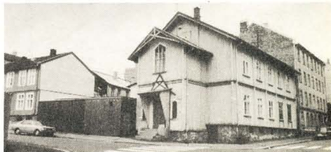
"Betania" har fått nytt gjerde og tak over inngangsdøra.Flott,men hvorfor ikke den opprinnelige takformen?
