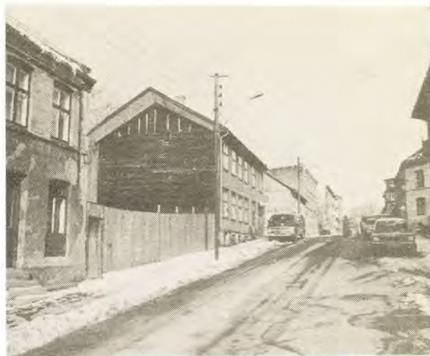
På hver side av Norderhovsgata 22 (midt på bildet) sees de åpne tomtene nr. 20 og 24. Nr. 22 og nr. 26 forfaller fordi Bjerke vil rive og bygge på hele området.
