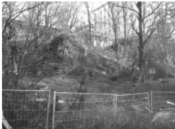
Et av de siste gamle trebusene ved Kampentrappa, Brinken 63, er nå jevnet med jorden. (Foto: Kristin Hagen)
