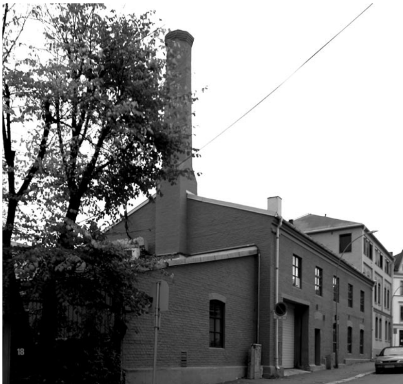
Verkstedsbygningen i Kampengata 18 er i dag et karakteristisk innslag i gatebildet, med fabrikkpipa som forteller om eldre tiders næringsvirksomhet på Kampen. Pipa – "25 alen høy" – skulle fjerne røyk og damp fra dampkjelen som den første fabrikkbenyttet. Ifølge byggeplanene skal det bygges karnapper på verkstedsbygningen, den vil bli kraftig beskåret i bakkant. Tilbygget med pulttak – opprinnelig smie – vil bli revet. Foto: Sverre Syversen
