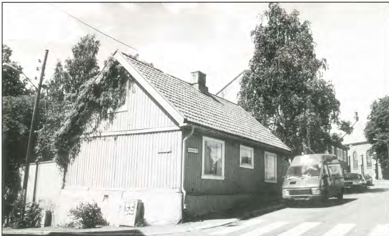
BORTE VEKK? Ullensakergata 8 ble revet i oktober. En tilnærmet kopi av huset skal oppføres på hjørnet og stå ferdig neste sommer. Byantikvaren krav til at huset gjennombygges i tilnærmet kopi.
