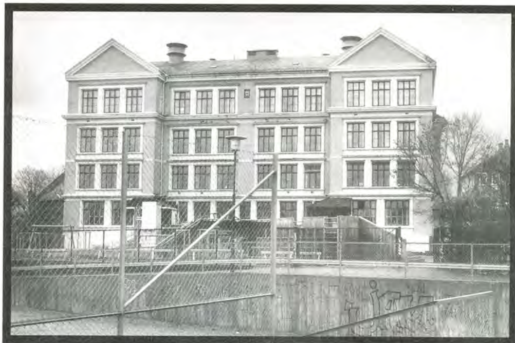
KAPASITETEN SPRENGT: Med de økende barnetall fram mot årtusenskiftet ser vi at det allerede om et par år spøker for ungdomstrinnet på Kampen skole.
