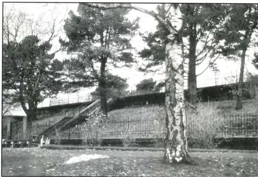
Trykkbassenget i Kampen park er en del av det omfattende arbeidet som skjer i «Tøyen kulturpark». I skrivende stund er byggestart i trykkbassenget satt til våren '97.
